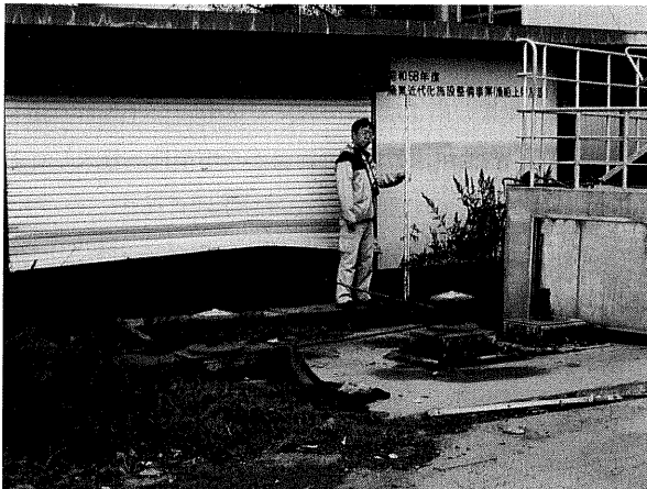
写真—2 大津港での壁に残された痕跡(油跡)
