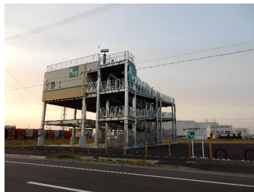
中野5丁目津波避難タワー
