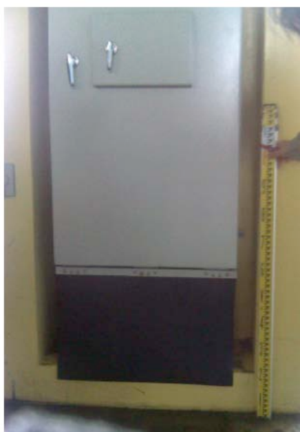
写真 1 電源盤による浸水高さの測定
